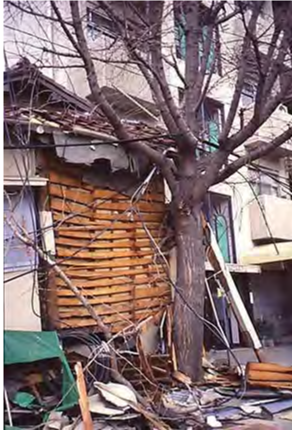
建物の崩壊を支えた街路樹
